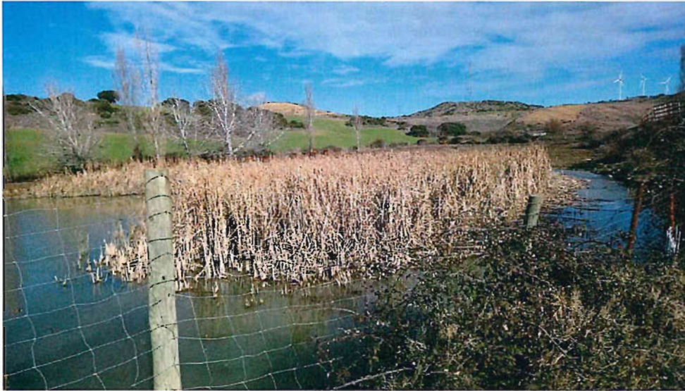
Imagen 13: Estado actual de la balsa.
